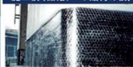
施工前(繊維シート貼付け後)
