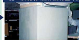
施工状況(表面保護材塗布)
