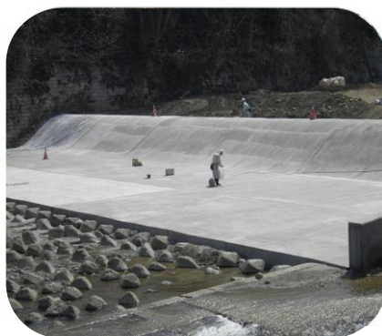
河川固定堰改修
