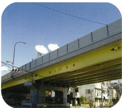
道路陸橋表面保護
