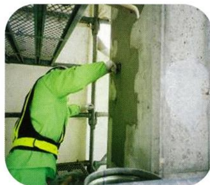
RB-断面修復工法
