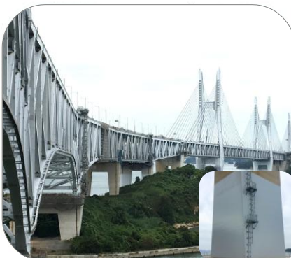
繊維巻立て表面仕上げ材工法
