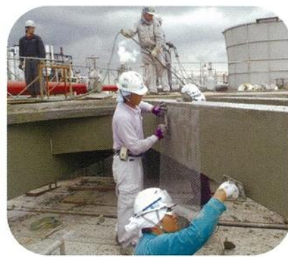
工場施設改修
