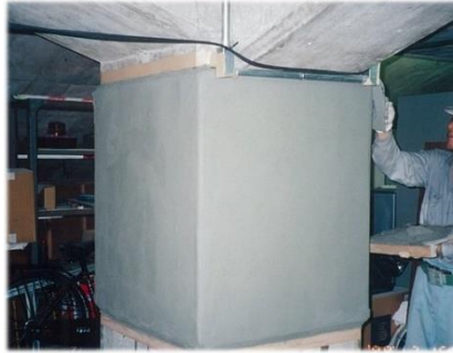
施工状況(表面保護材塗布)
