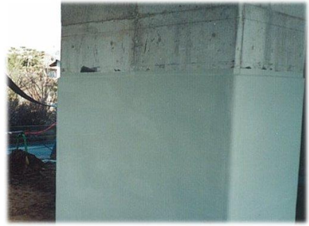
施工後(表面仕上げ材塗布後)
