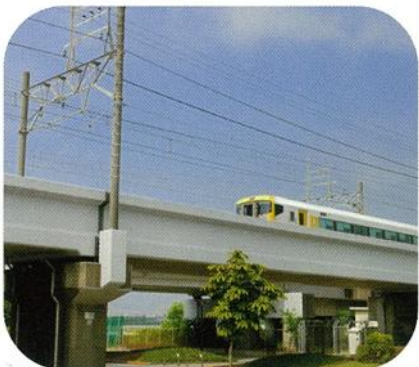
弾性型ポリマーセメント 表面保護・剥落防止対策 旧NETIS登録№KT-100089-A
