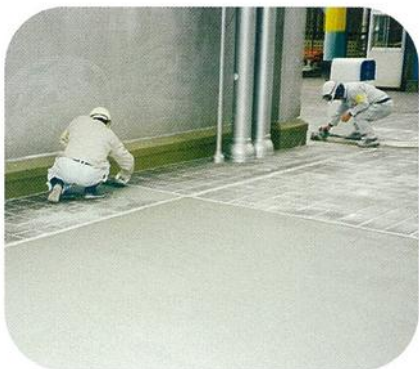
東京タワー クリンカータイル改修
