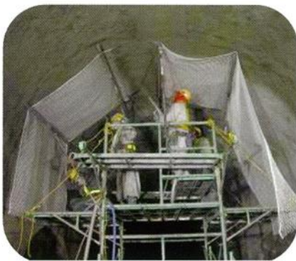
SANショット工法 (トンネル覆工剥落防止対策) 旧NETIS登録№KT-090013
