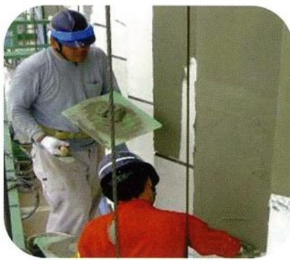
建物外壁改修
