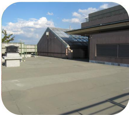
屋上防水下地
